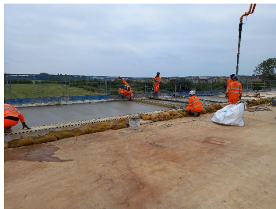
Image 6 Verge infill pours
