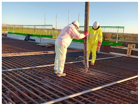
Image 10 Diaphragm concrete pour.
